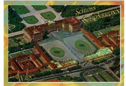
00090 WPK Luft Wien Schönbrunn
